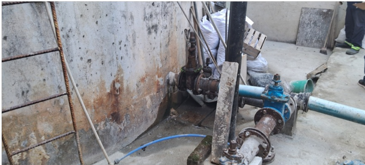
Foto 15 - Lixo encontrado no reservatório
