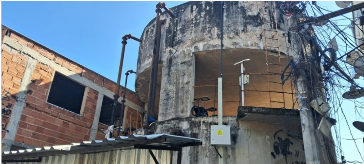
Foto 1 – Reservatório com duas células
